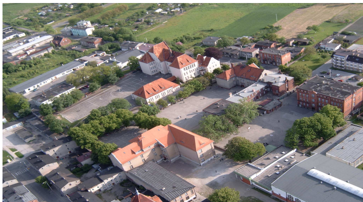
Widok na kompleks Szkół Podstawowych Nr 2 i Nr 3 oraz Gimnazjum Nr 1 w Chełmży
