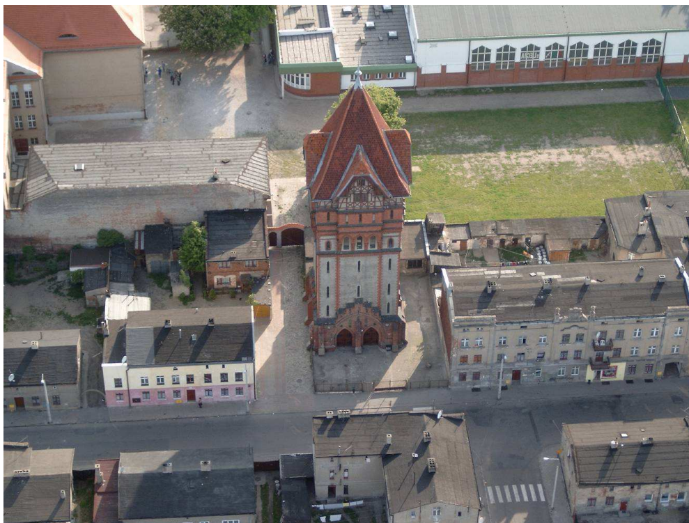
Fot. Wieża ciśnień.
