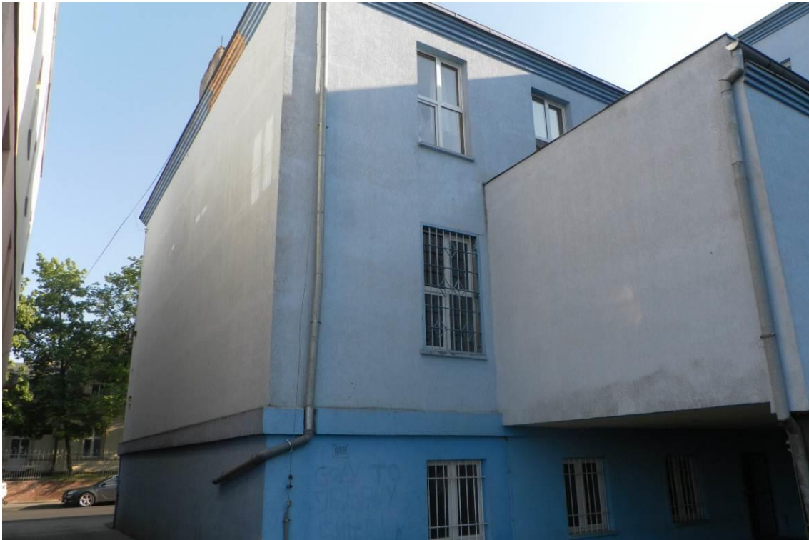
Zdj. 57 Budynek Krytej Pływalni od strony zachodniej (przedszkola)
