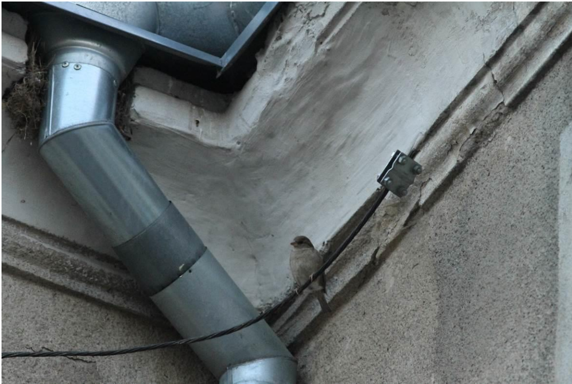
Zdj. 8 Gniazdo wróbla w przestrzeni między rynną a ścianą oraz stanowisko lęgowe jerzyka w budynku Szkoły Podstawowej nr 3 w Chełmży
