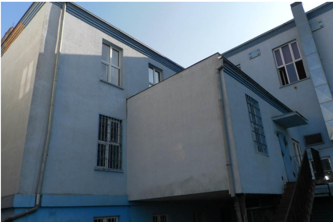
Zdj. 58 Budynek Krytej Pływalni od strony zachodniej (przedszkola)
