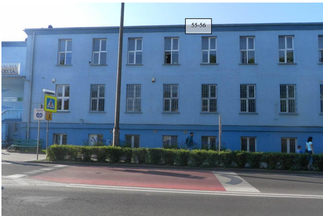
Zdj. 53 Budynek Krytej Pływalni od strony północnej z numerami zdjęć naniesionymi w miejscu ich wykonania. Miejsca te przedstawiają kolejne fotografie z odpowiednimi numerami
