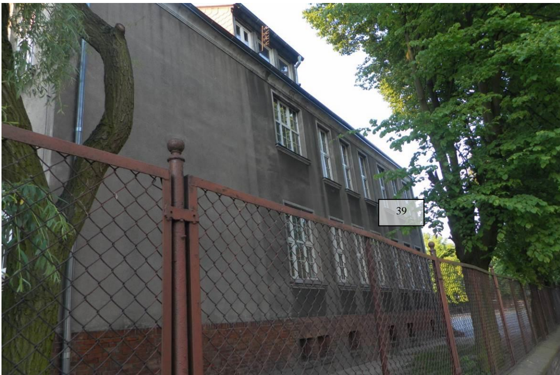
Zdj. 38 Budynek A Szkoły Podstawowej nr 3 od strony północno-zachodniej z numerami zdjęć naniesionymi w miejscu ich wykonania. Miejsca te przedstawiają kolejne fotografie z odpowiednimi numerami
