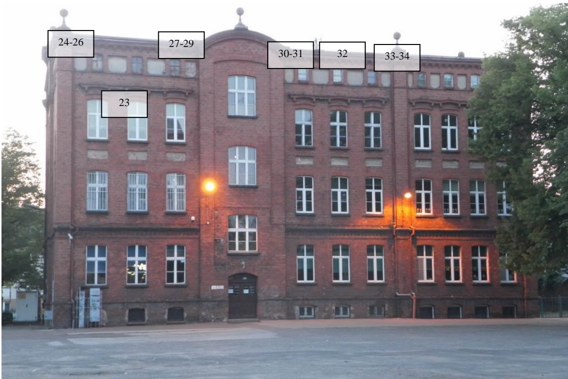
Zdj. 22 Budynek Szkoły podstawowej nr 2 od strony południowo-zachodniej z numerami zdjęć naniesionymi w miejscu ich wykonania. Miejsca te przedstawiają kolejne fotografie z odpowiednimi numerami
