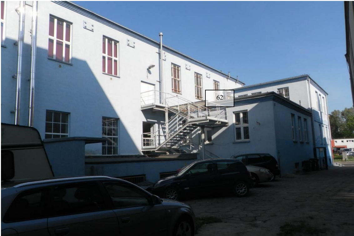
Zdj. 61 Budynek Krytej Pływalni od strony wschodniej z numerem zdjęcia naniesionymi w miejscu jego wykonania. Miejsca te przedstawia kolejna fotografia z odpowiednim numerem
