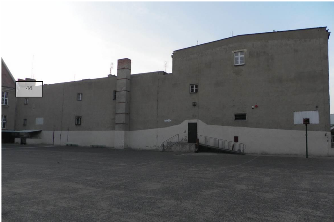
Zdj. 45 Budynek B Szkoły Podstawowej nr 3 od strony północno-zachodniej z numerami zdjęć naniesionymi w miejscu ich wykonania. Miejsca te przedstawiają kolejne fotografie z odpowiednimi numerami
