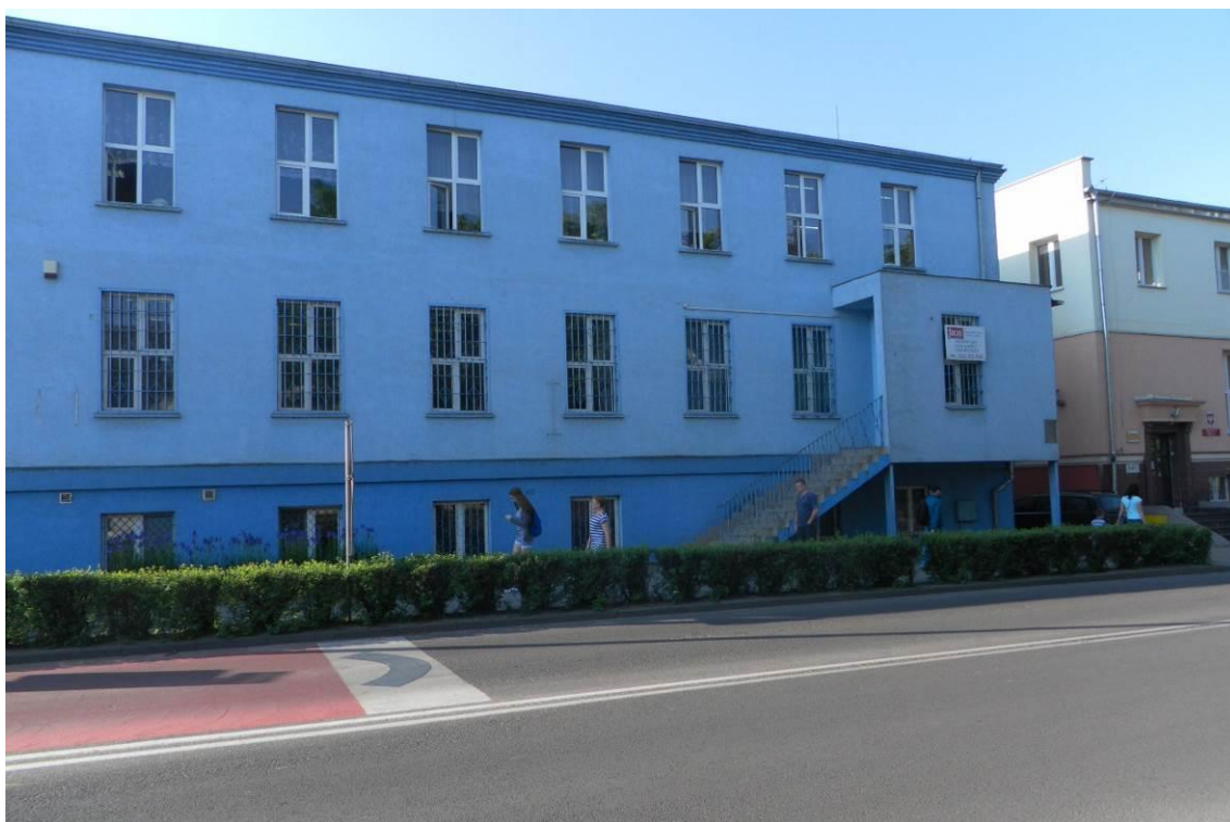
Zdj. 54 Budynek Krytej Pływalni od strony północnej
