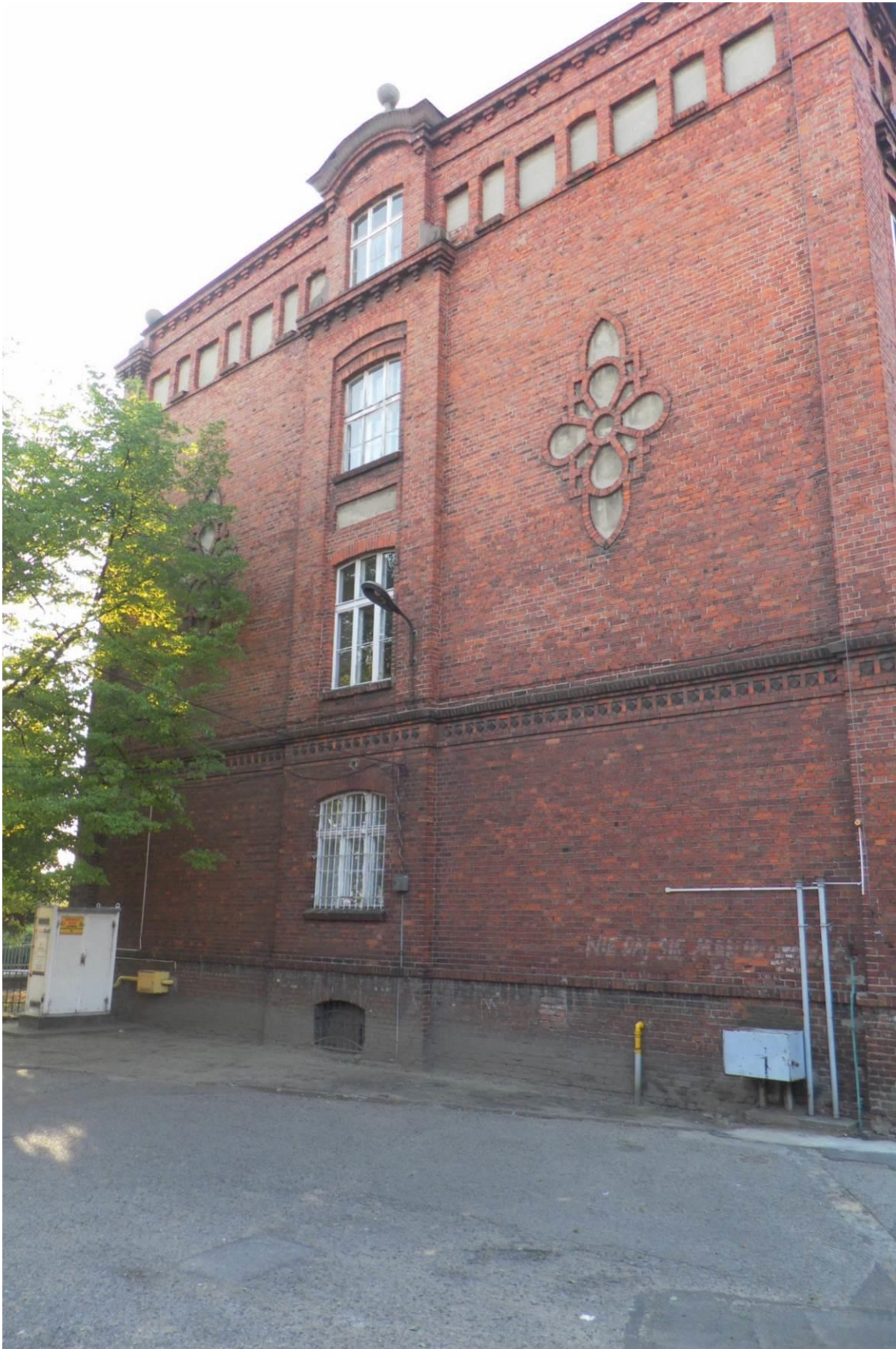
Zdj. 19 Budynek Szkoły Podstawowej nr 2 od strony północno-zachodniej
