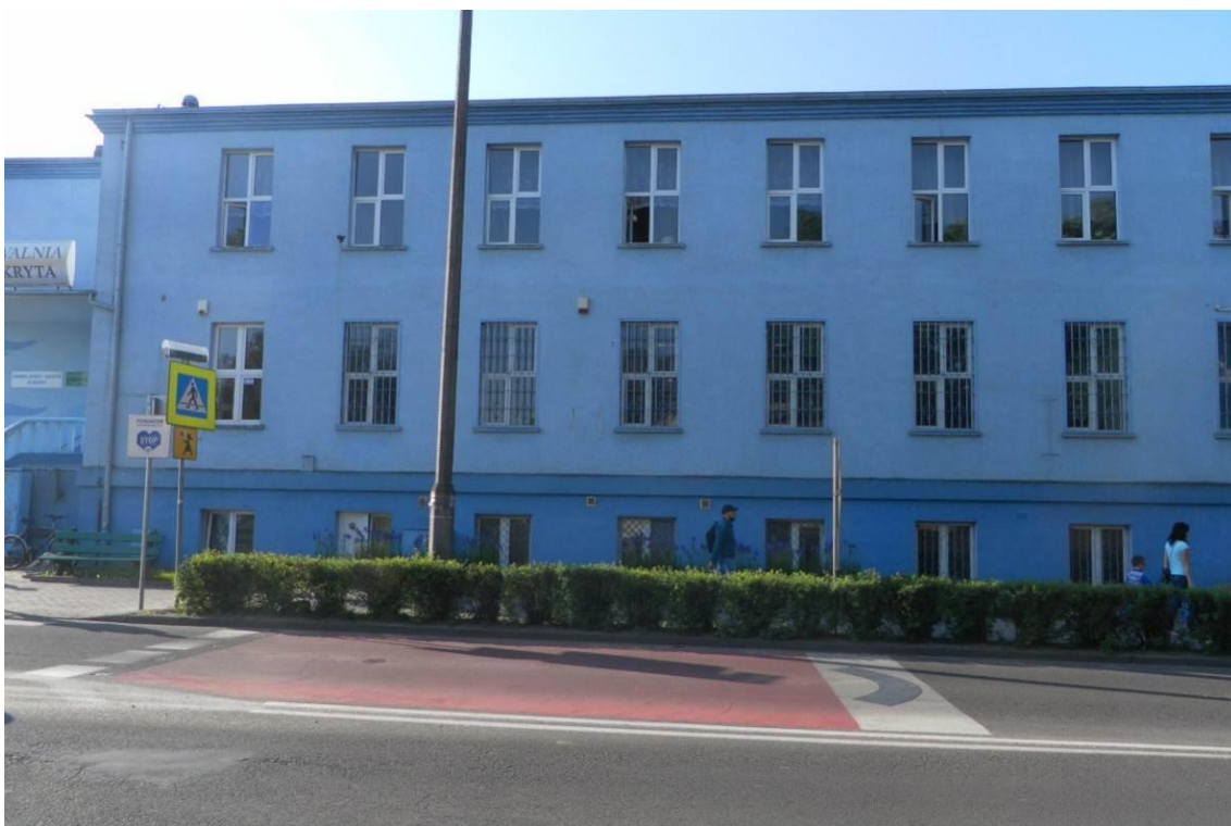
Zdj. 4 Budynek Krytej Pływalni od ulicy Bydgoskiej
