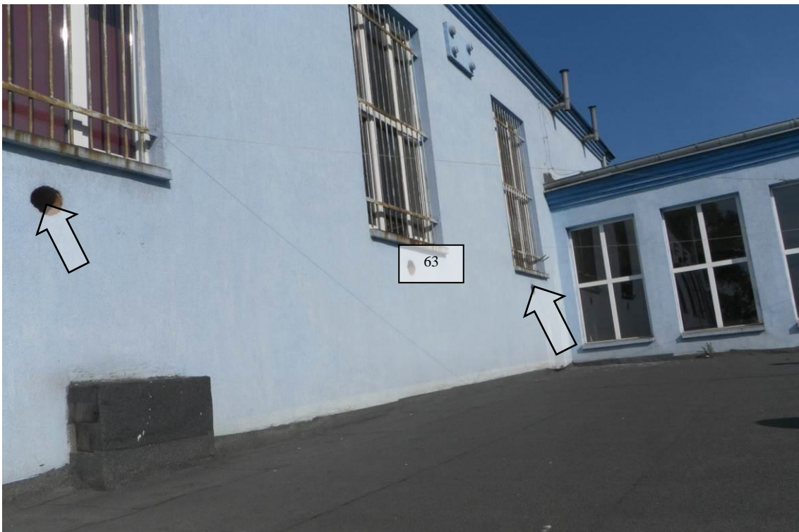
Zdj. 62 Budynek Krytej Pływalni od strony wschodniej z numerem zdjęcia naniesionym w miejscu jego wykonania. Miejsca te przedstawia kolejna fotografia z odpowiednim numerem. Potencjalne siedliska (strzałki)
