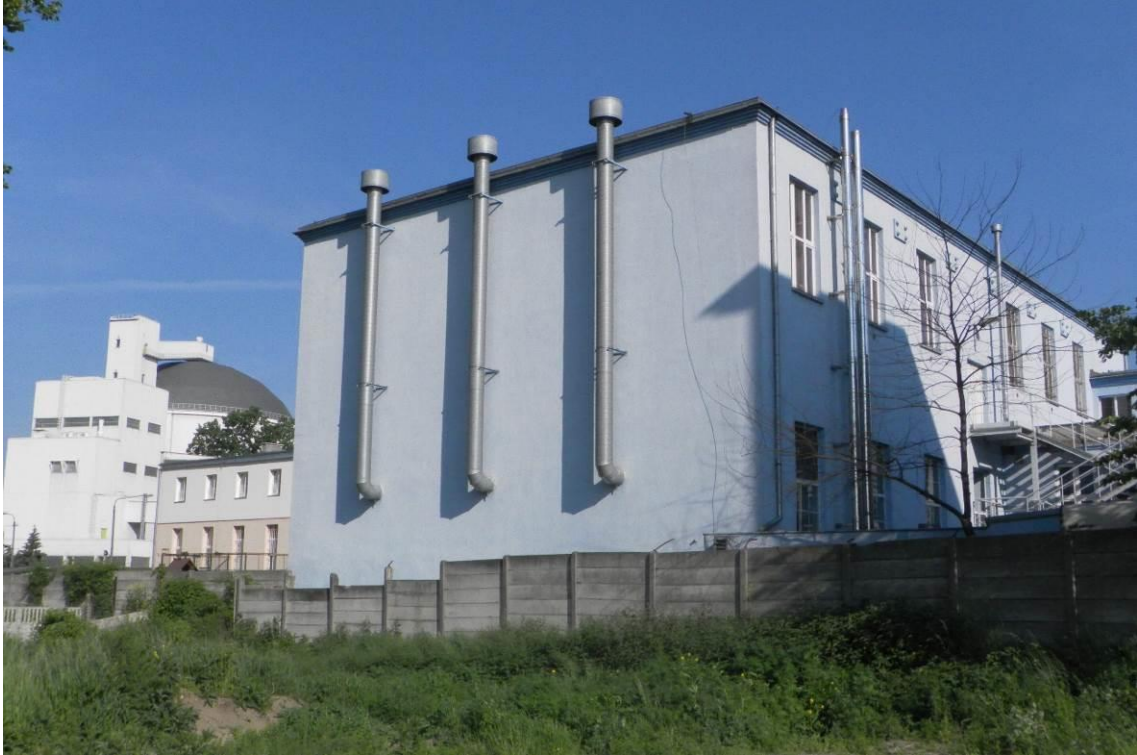
Zdj. 65 Budynek Krytej Pływalni od strony południowej
