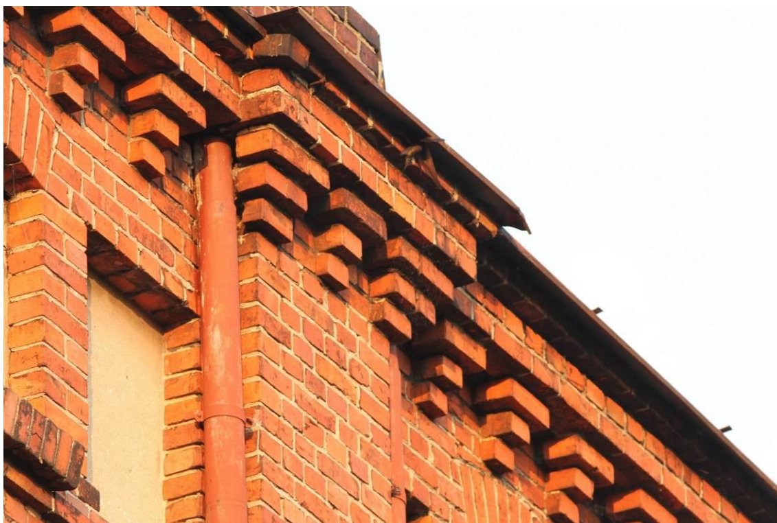
Zdj. 6 Jerzyk dolatujący do gniazda w szczelinie budynku Szkoły Podstawowej nr 2 w Chełmży
