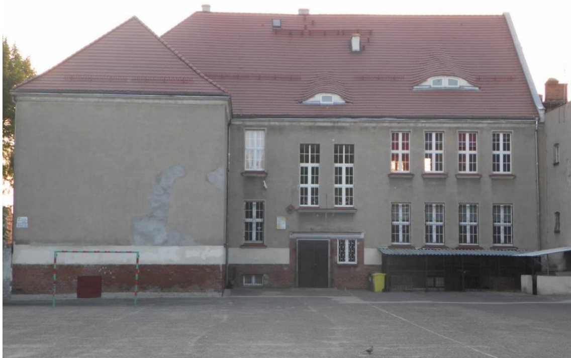
Zdj. 2 Budynek A Szkoły Podstawowej nr 3 od strony boiska szkolnego
