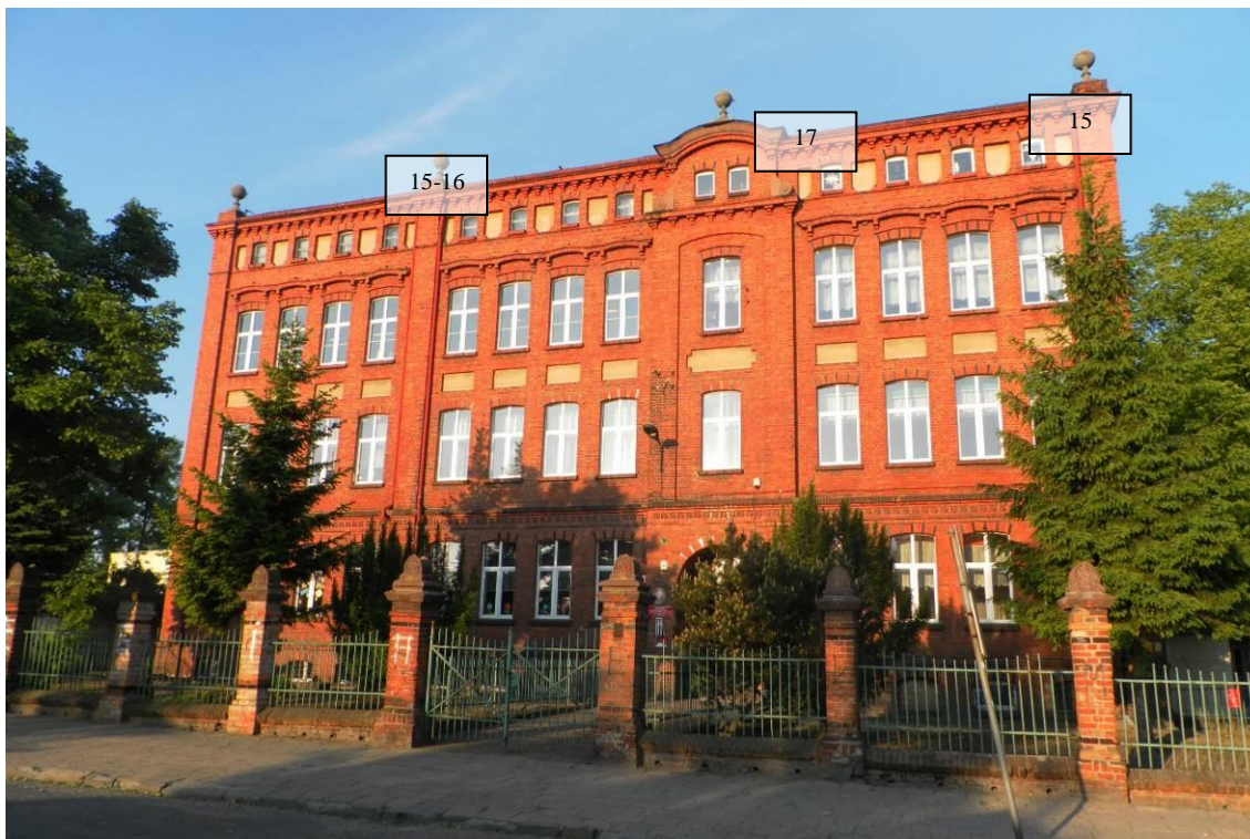
Zdj. 14 Budynek Szkoły podstawowej nr 2 od strony północno-wschodniej z numerami zdjęć naniesionymi w miejscu ich wykonania. Miejsca te przedstawiają kolejne fotografie z odpowiednimi numerami
