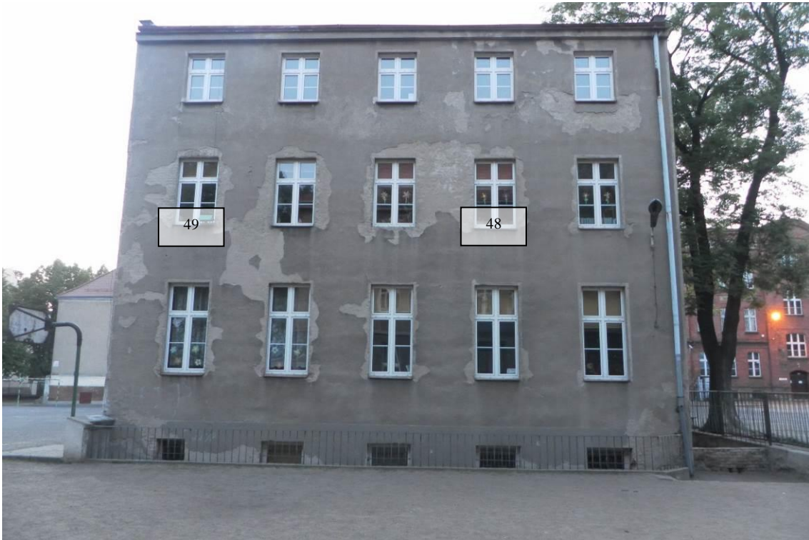
Zdj. 47 Budynek B Szkoły Podstawowej nr 3 od strony południowo-zachodniej z numerami zdjęć naniesionymi w miejscu ich wykonania. Miejsca te przedstawiają kolejne fotografie z odpowiednimi numerami
