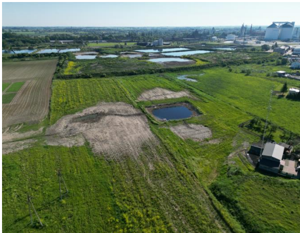
Fot. Teren inwestycji (22.05).
