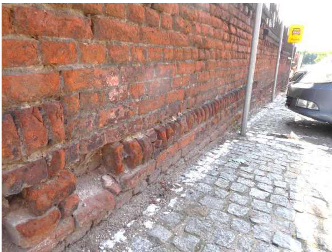
Fot.5. Lico muru – widok od ul. Sądowej
