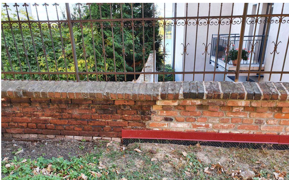
Fot.21. Chełmża, parafia pw. św. Mikołaja Bpa. Południowy odcinek ogrodzenia po niedawnych pracach remontowych. Na zdjęciu widoczna granica pomiędzy częścią remontowaną (graniczącą z działką 143) a nieremontowaną (graniczącą z działkami 144/1 i 144/2).
