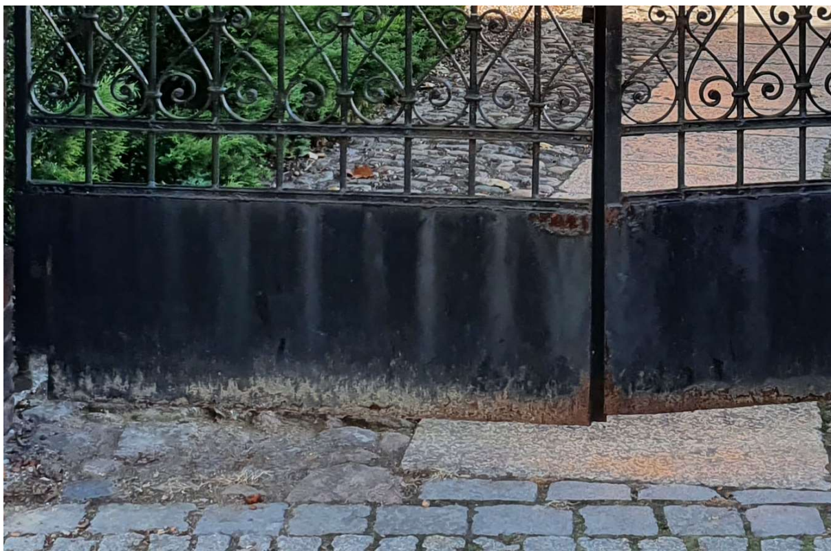
Fot.10. Chełmża, parafia pw. św. Mikołaja Bpa. Brama od strony ulicy Mikołaja Kopernika. Stan zachowania obicia w dolnej części skrzydeł.
