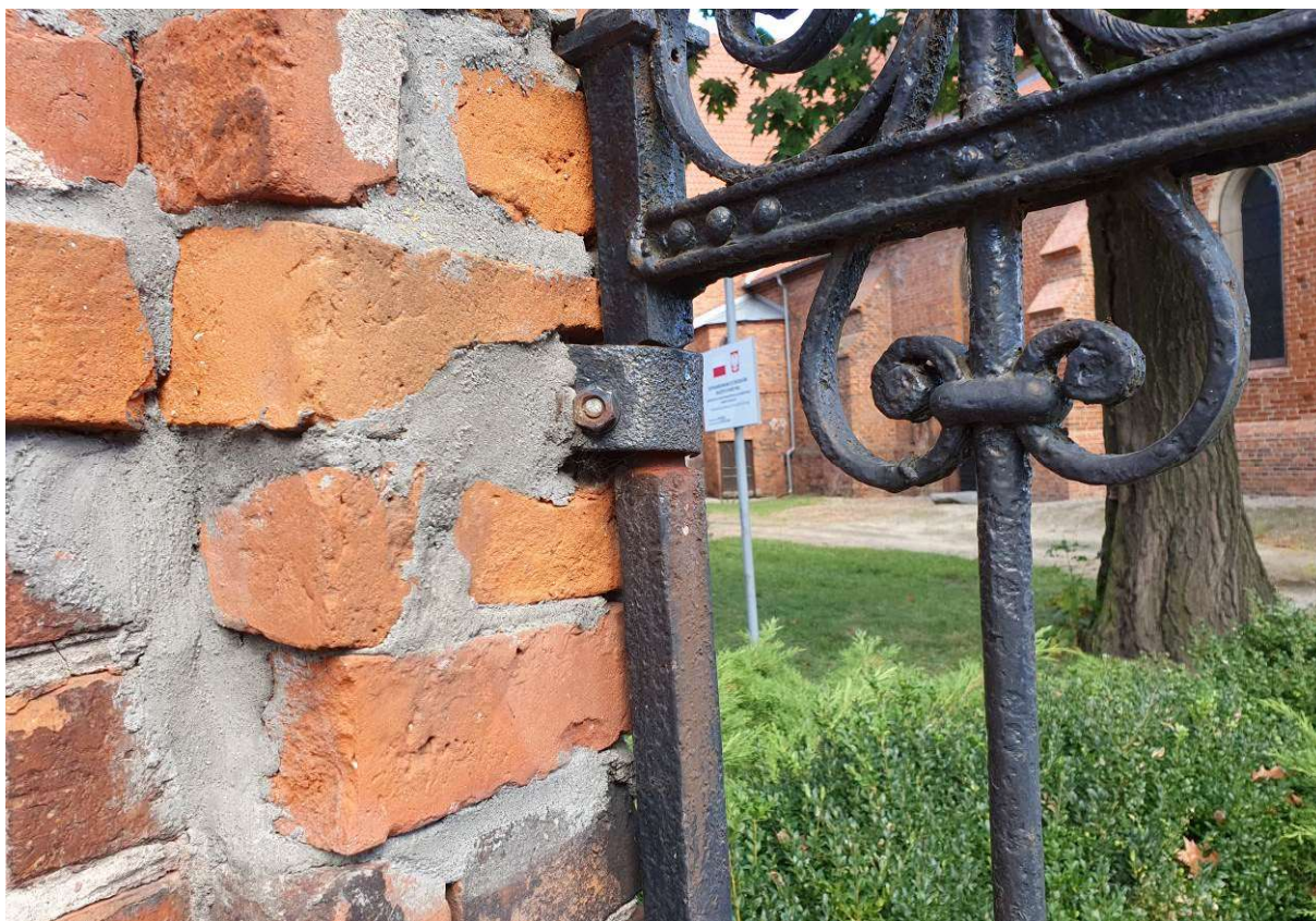
Fot.32. Chełmża, parafia pw. św. Mikołaja Bpa. Detal wtórnego osadzenia skrzydła bramy w murze.
