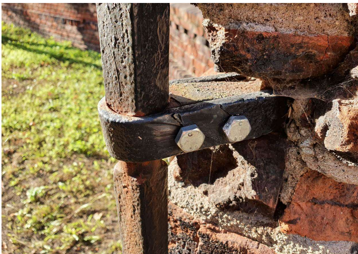
Fot.31. Chełmża, parafia pw. św. Mikołaja Bpa. Detal wtórnego osadzenia skrzydła bramy w murze.
