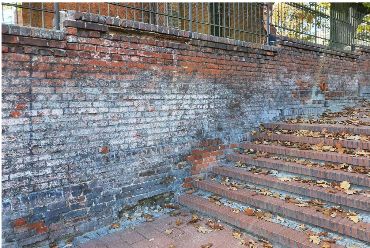
Fot.26. Chełmża, parafia pw. św. Mikołaja Bpa. Przęsła wschodniej strony ogrodzenia w widoku od strony ulicy Strzeleckiej. W okolicach narożnika południowo-wschodniego występuje kumulacja soli rozpuszczalnych w wodzie oraz fragmentów noszących ślady ich działania.
